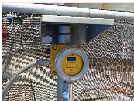
ภาพที่ 2.2-31 ระบบตรวจจับการรั่วไหลของฟอर्मัลดีไฮด์ (Fixed Gas Detector)
