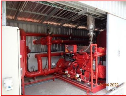
ภาพที่ 2.2-24 ระบบปั๊มดับเพลิง
