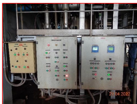
ภาพที่ 2.2-4 จอแสดงผล (Display) ของระบบควบคุม Scrubber
