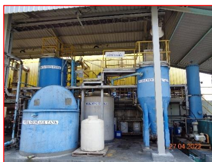
ภาพที่ 2.2-6 ระบบบำบัดน้ำเสียเบื้องต้น
