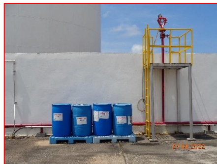
ภาพที่ 2.2-38 ระบบดับเพลิงบริเวณคั่นคอนกรีต รอบถังเมทานอล
