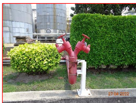
ภาพที่ 2.2-34 ระบบดับเพลิงบริเวณคันคอนกรีตรอบถัง เก็บฟอर्मัลดีไฮด์
