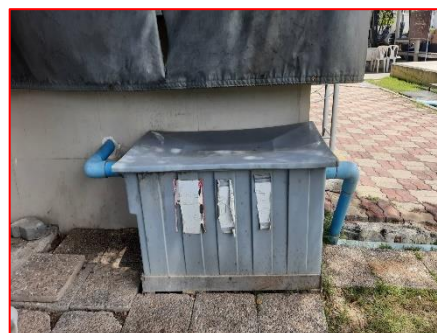
ภาพที่ 2.2-6 ระบบบำบัดน้ำเสียเบื้องต้น
