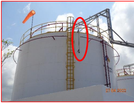
ภาพที่ 2.2-35 Temperature and Level Detector และ Temperature and Level Alarm
